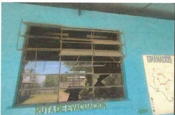
Foto 3: Mejoramiento e instalación de ventanas.
