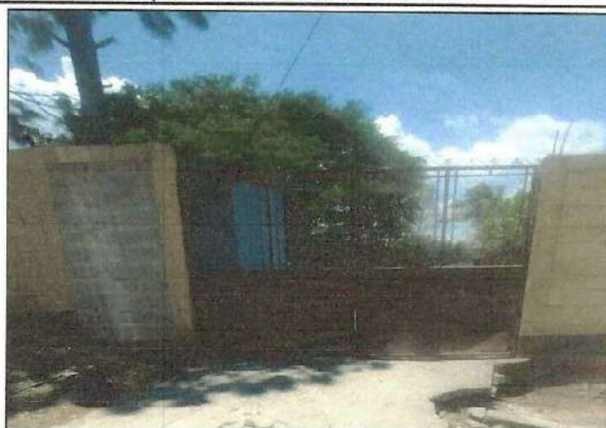
Foto 2: Mejoramiento de portón de ingreso.
